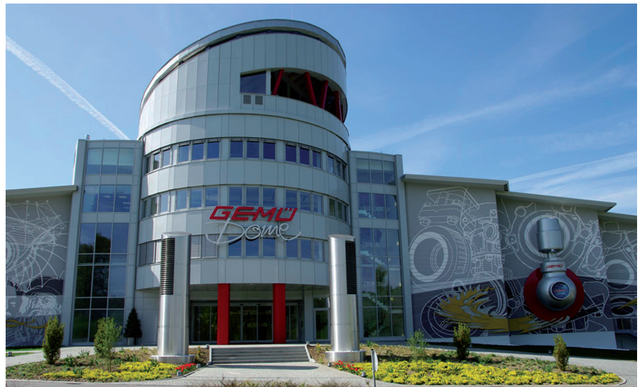
Bild 1. Der mit einer Photovoltaik-Anlage ausgerüstete Drehturm überragt das imposante Gebäude
